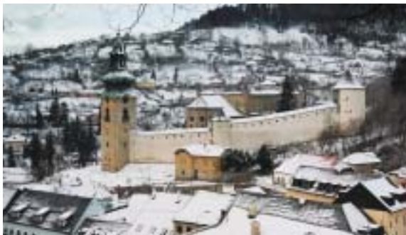
AZ ÓVÁR ÉSZAKI LÁTKÉPE; A KÖZPONTI ÉPÜLET GÓTIKUS TEMPLOMBÓL LETT ÁTÉPÍTVE
